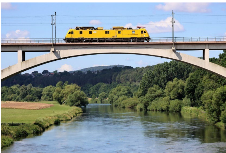
Das Instandhaltungsfahrzeug für Oberleitungen - Baureihe 711, Copyright: Deutsche Bahn AG / Wolfgang Klee
