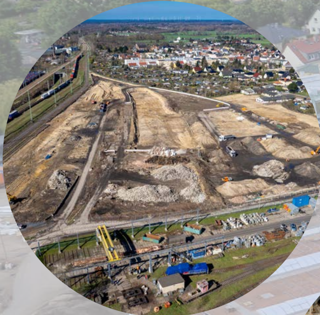
Baufeldfreimachung Westliches Baufeld Oktober 2022
