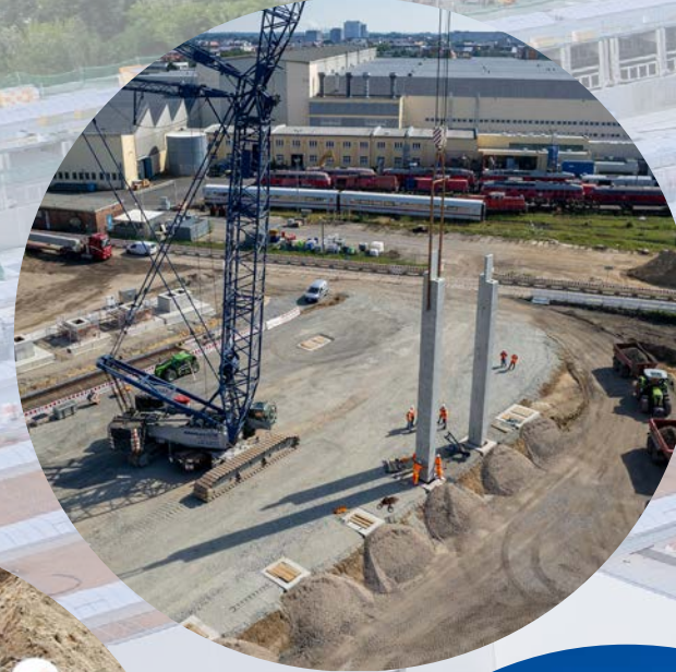
Einbau Stützen startet Mai 2024
