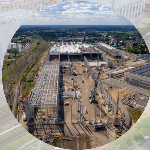
Die Gleishalle nimmt Kontur an Mai 2025
