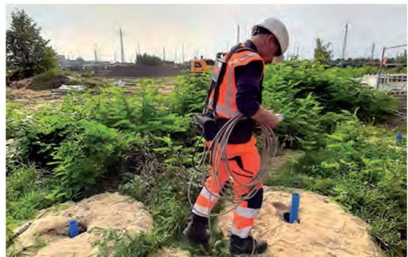
*Kampfmittelsuche mit Hilfe einer Bohrlochsondierung auf dem östlichen Baufeld*
